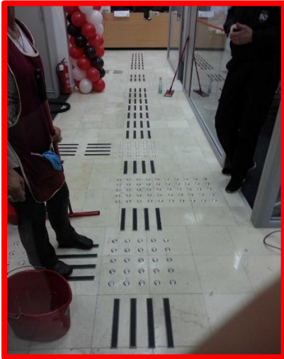
Slika 1 Neutrezno: Taktilnih oznak je preveč, saj s tipom oz. belo palico ne moremo zaznati tako kratkih vodilnih linij in različnih vzorcev. Obenem so taktilne oznake lahko ovira za vse, ki težko dvigujejo noge, zato naj se postavljajo samo tam, kjer je to nujno in kjer lahko koristijo slepim in slabovidnim.
