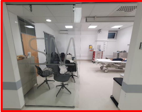
Slika 1 Neustrezno: Steklenih sten, ki predeljujejo prostore, slabovidni ne zaznajo. Posebej so nevarni slabo vidni vertikalni robovi.
