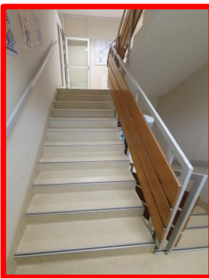
Slika 1 Neustrezno: Oprijemala ne segajo do zadnje stopnice. Izpostavljen rob je nevaren.
