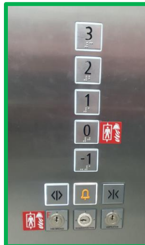
Slika 1 Neustrezno: dvigalo s kontrolno ploščo na dotik in slabo kontrastnimi napisi ni dostopno ljudem z okvarami vida.
