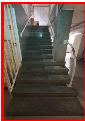
Slika 1 Neustrezno: Oprijemala ne segajo do zadnje stopnice. Izpostavljen rob je nevaren.
