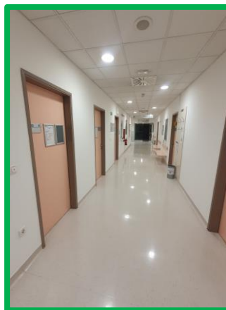
Slika 1 Neustrezno: Ker so vrata enaka kot stena, se jih težko vizualno zazna.
