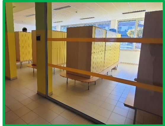
Slika 1 Neustrezno: Steklenih sten, ki predeljujejo prostore, slabovidni ne zaznajo. Posebej so nevarni slabo vidni vertikalni robovi.
