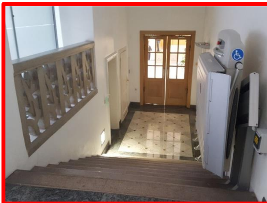
Slika 1 Neustrezno: Stopniščna ploščad je uporabna le za uporabnike invalidskih vozičkov in le v primerih, ko je na voljo tudi pomoč osebja. Zaradi umestitve stopniščne ploščadi na oprijemalo, so prikrajšane druge gibalno ovirane osebe, ki potrebujejo oporo oprijemala pri hoji po stopnicah.
