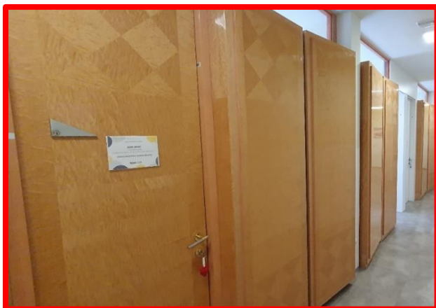
Slika 1 Neustrezno: Ker so vrata enaka kot stena, se jih težko vizualno zazna.
