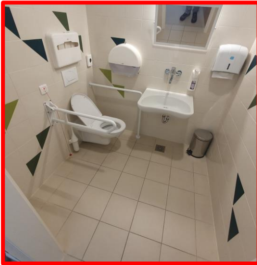
Slika 1 Neustrezno: Razporeditev opreme onemogoča uporabo sanitarij gibalno oviranim: umivalnik je preblizu školjke, brisačke so nedosegljive z vozička, premično ogledalo nima kljuke, ki bi omogočala, da se jo premika iz vozička, pipa je previsoko.
