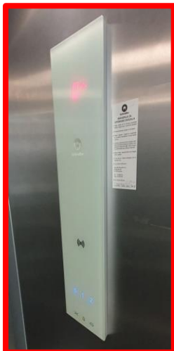
Slika 1 Neustrezno: dvigalo s kontrolno ploščo na dotik in slabo kontrastnimi napisi ni dostopno ljudem z okvarami vida.
