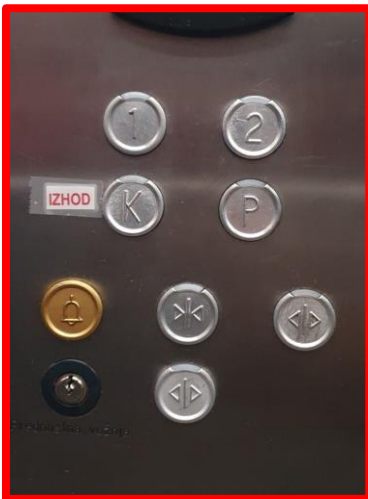
Slika 1 Neustrezno: dvigalo s kontrolno ploščo na dotik in slabo kontrastnimi napisi ni dostopno ljudem z okvarami vida.
